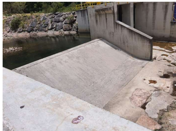
Presa de derivación Runatullo II
