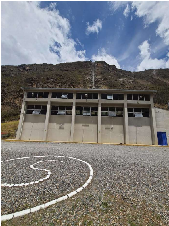
Vista panorámica de casa de máquinas Runatullo II con la tubería forzada
