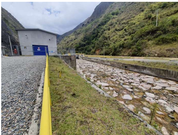
Vista panorámica de casa de máquinas y canal de descarga Runatullo II
