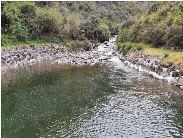
Vista panorámica del río Runatullo, aguas arriba del sitio de presa y captación
