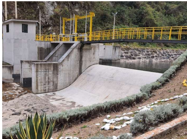
Vista lateral de presa de derivación Runatullo II
