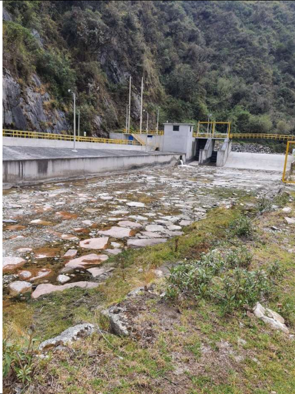
Vista frontal de presa y canal de rebose de Runatullo II
